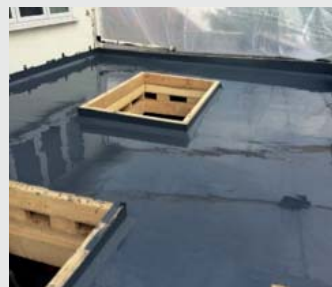
Exterior Ply/Roofdek Boards
